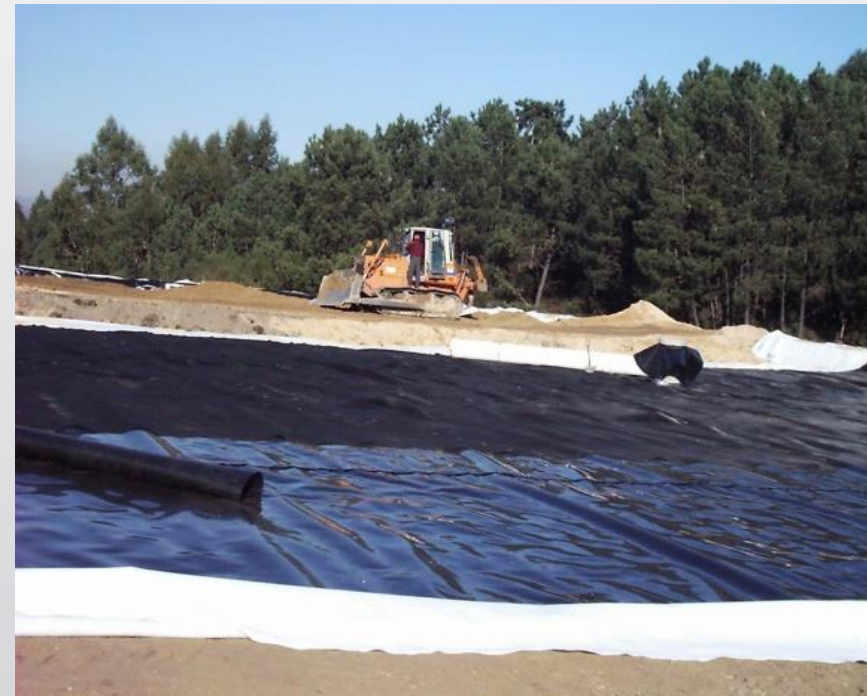
Impermeabilização da massa de resíduos
